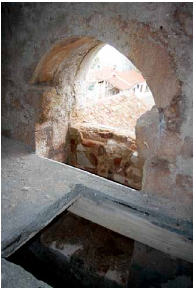
3. Djelomično zazidana monofora na sjevernoj stranici trećeg kata zvonika (foto: E. Motušić)
